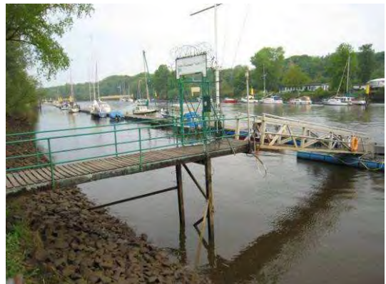
Abb. 29: Sportbootanleger am südlichen Lesum-Ufer; Steinschüttung zur Ufersicherung
